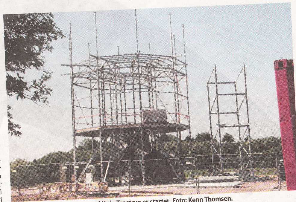
Byggeriet af det nye aircenter i Høje Taastrup er startet. Foto: Kenn Thomsen.
